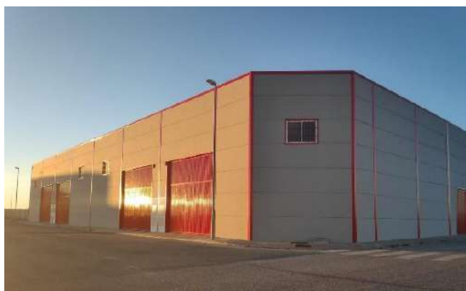
Figura 62. Nave industrial en el Polígono Gandul
